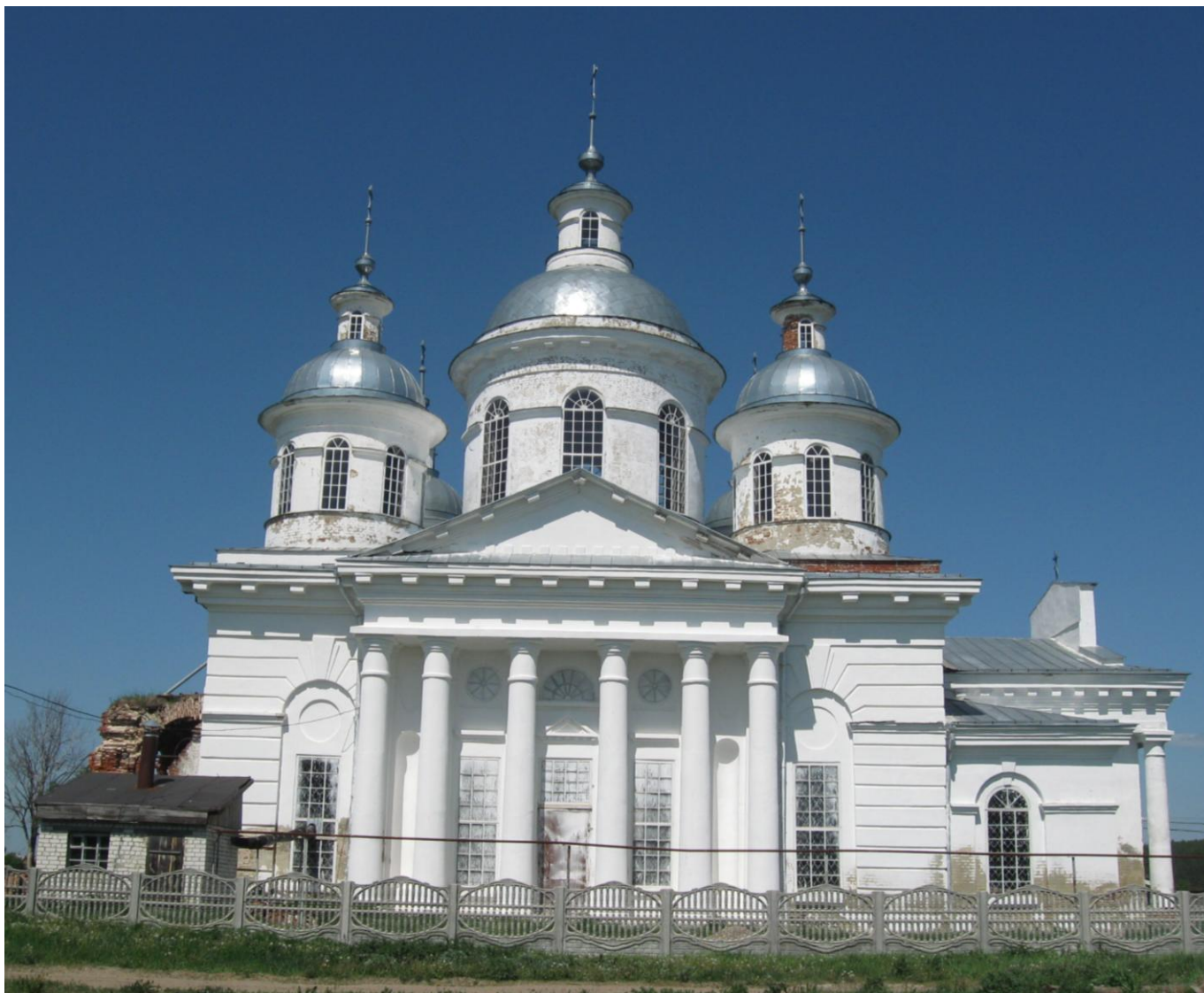
Фото 1. Фасад в осях «б-12/А»
