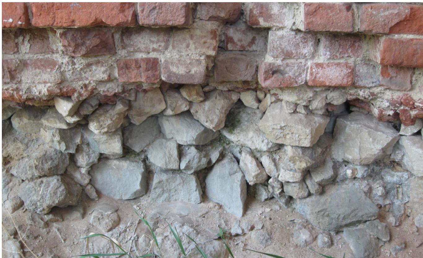
Фото 5. Фундамент в осях «б-7/Е»
