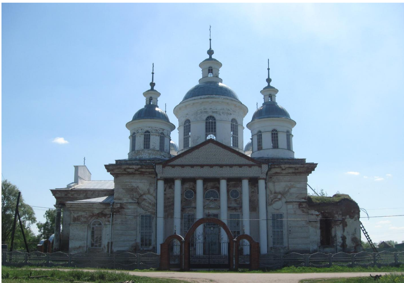
Фото 3. Фасад в осях «12-6/Е»
