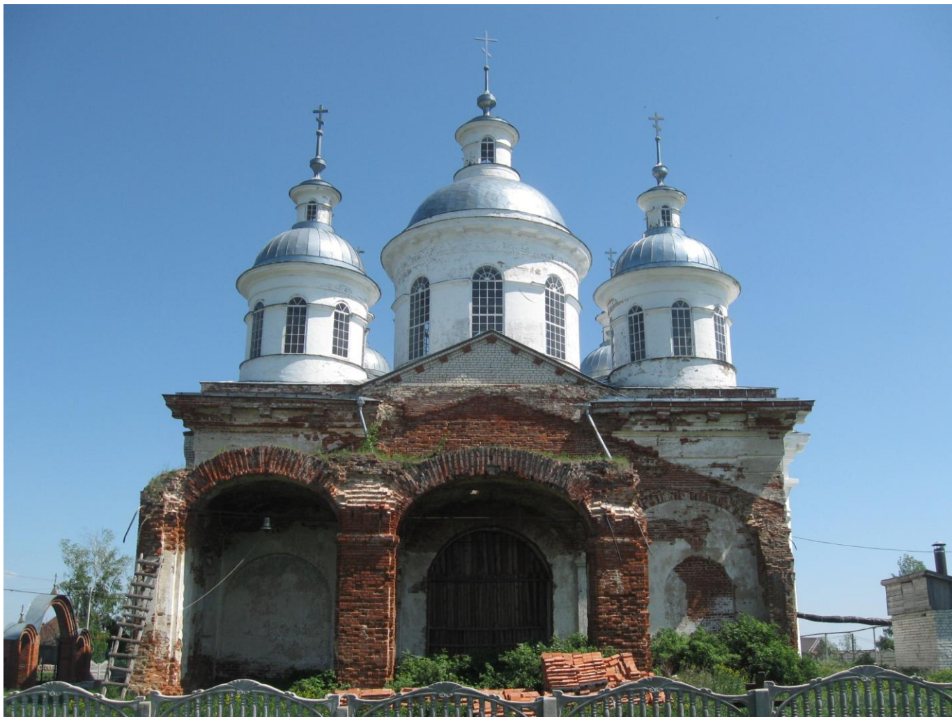
Фото 4. Фасад в осях «б/Е-А»
